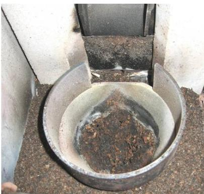
Fig. 11 : cendre dans la chambre de combustion
